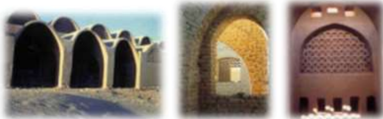
الصورة (12ب) السوق بباريس الجديدة العقود والقنوات الغاطسة مع الفتحات تخدم وظائف عملية وزخرفية
